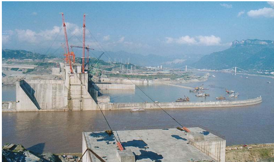
Obras de la presa de Las Tres Gargantas. Un ferry pasa por el espacio todavía abierto.
